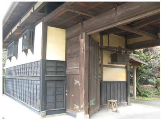
長屋門（門扉部）
